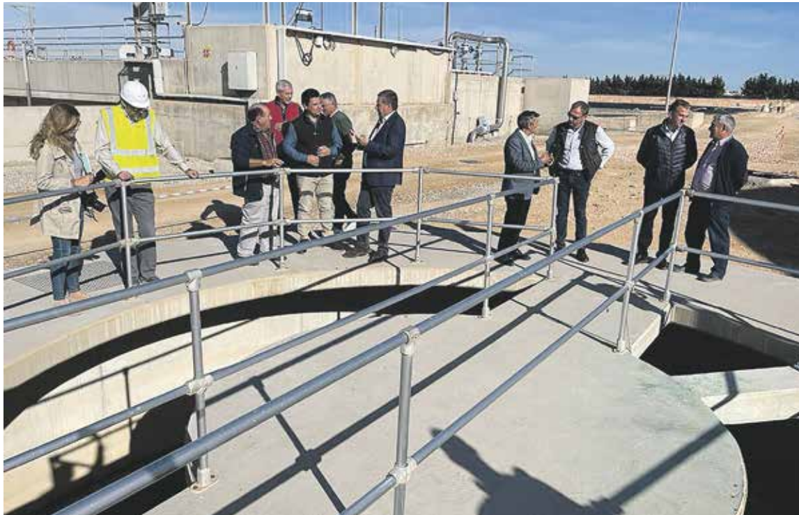
Visita realizada a la Estación Depuradora de San Javier. /FHMURCIA
