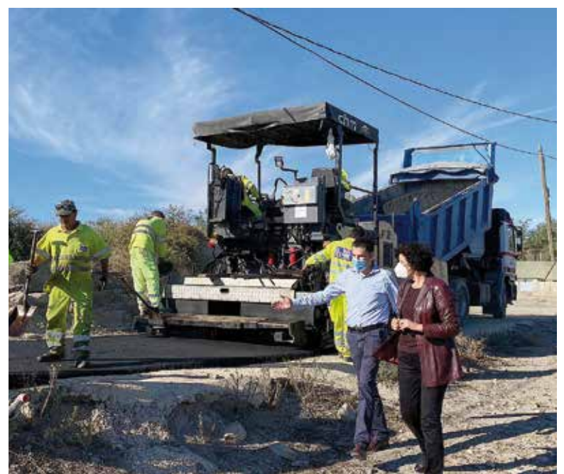
Sandoval y la alcaldesa de Puerto Lumbreras visitan las obras. /FHMURCIA
