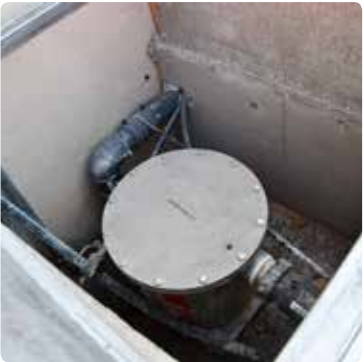
Instalación de LM INNOVATION. /C.G.G.
